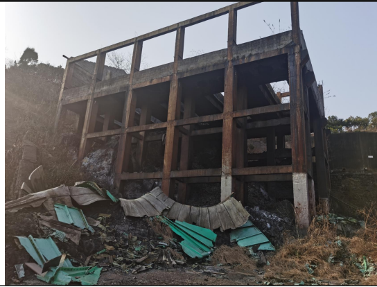
废弃的压滤车间（已无设备）
