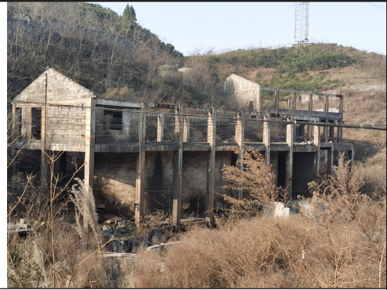
废弃的化工车间（已无设备）
