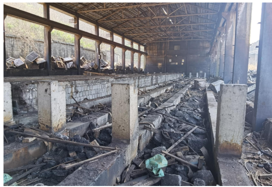
废弃的电解车间（已无设备）
